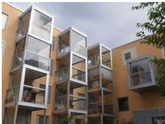
写真18：サービスハウス バルコニー
