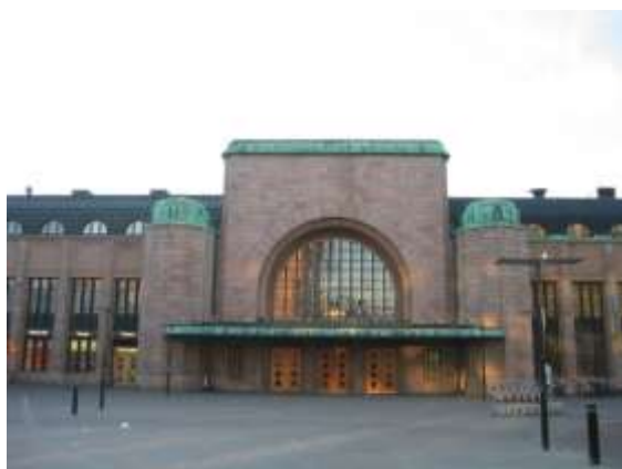
写真9：ヘルシンキ中央駅（1919） エリエル・サーリネン
