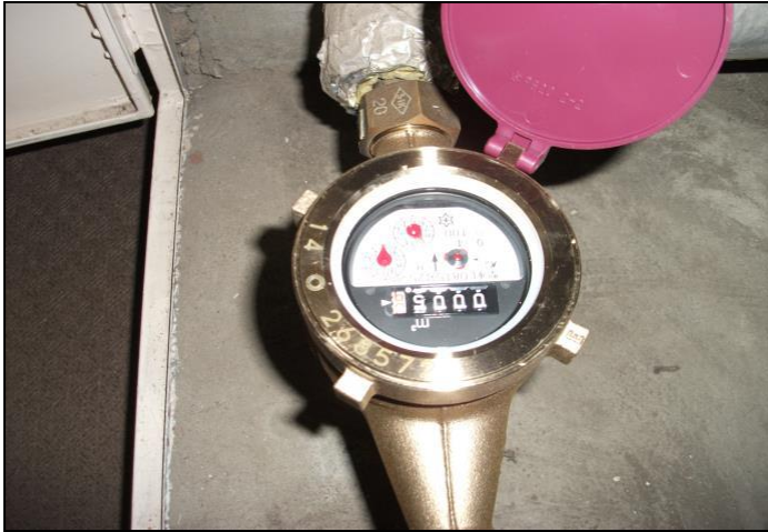
⑤漏水の検査
