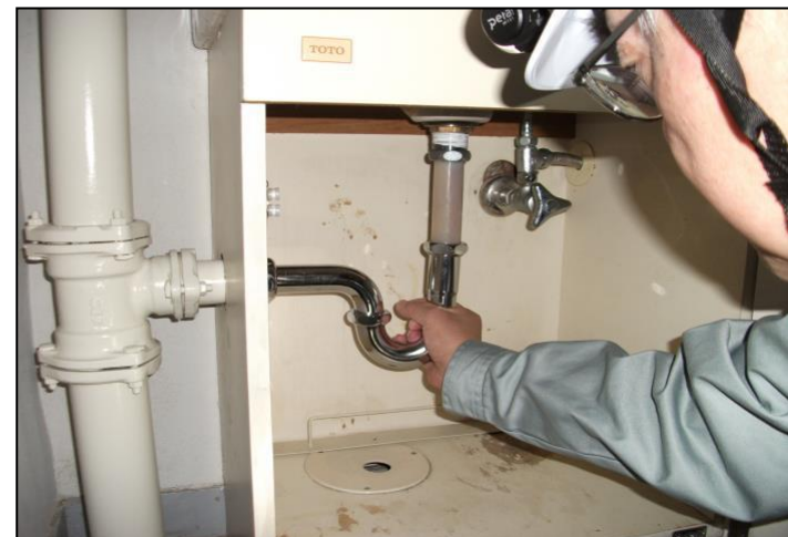
⑧設備配管の検査
