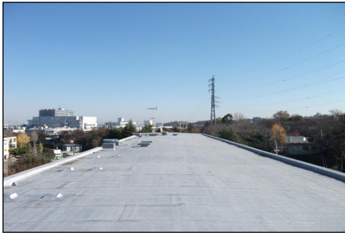
①屋上の検査
