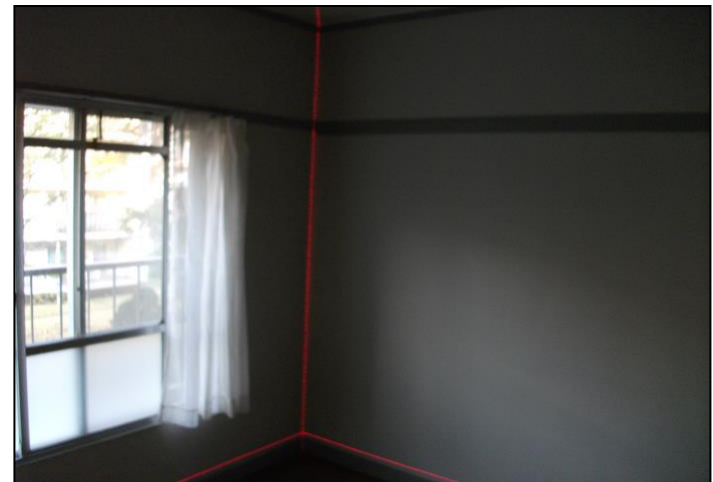
④居室の傾きの検査
