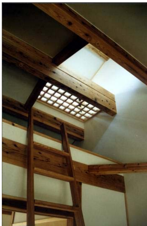
■越屋根の見上げ
